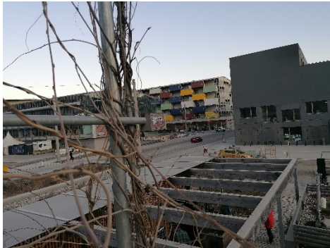
Bild 4: Der Blick vom Dach der Green Box auf die bereits fertige Volksschule Smart City rechts, dazwischen die Waagner Biro Straße, links ein Siedlungsbau – Da alle Bauten die möglichen Parkplätze im (offenen) Untergeschoß haben, wurden als Ersatz fürs Kellerabteil bunte Container an den Wohnungen angebracht.
